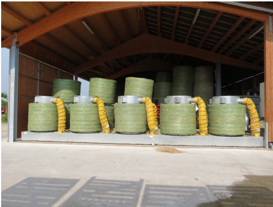
Bild 1: Belüftungstrocknung von Heuballen unter Dach. (Foto: Björn Bohne)
